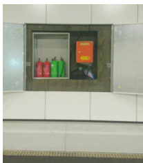
隧道行車通道緊急電話箱
