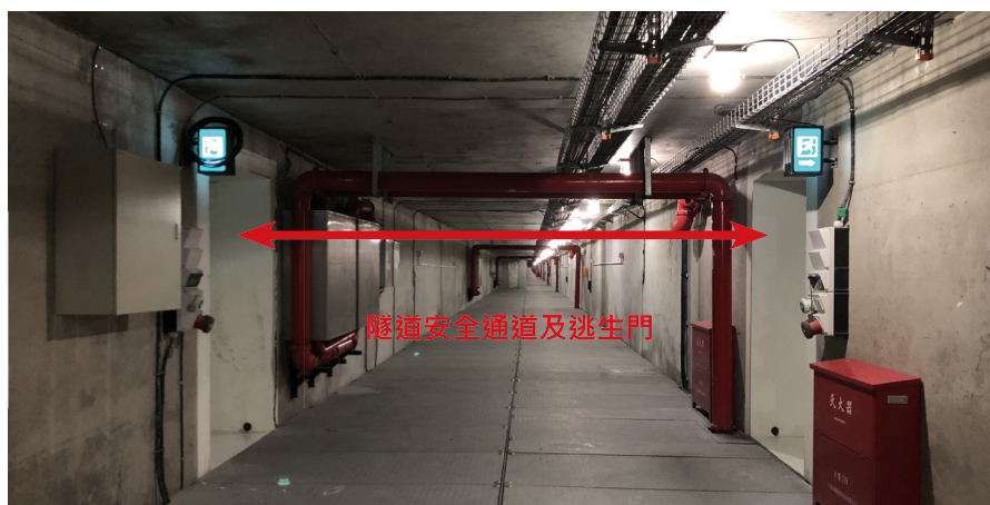
中央管廊逃生安全疏散通道及左右安全逃生門
