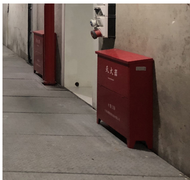
隧道行車孔滅火器箱
