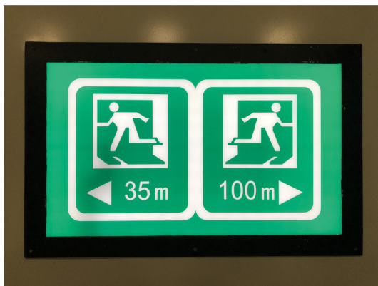
行車方向左側隧道管壁逃生疏散標識
