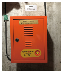
隧道中央管廊安全通道緊急電話分機
